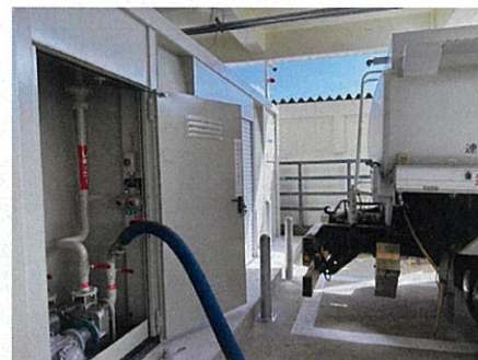
※地上タンクへローリーからの荷卸しをする様子
