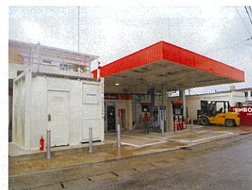
※改装後の給油所 左に10ftコンテナ型地上タンク、右側奥に20ftコンテナ型地上タンクが設置されています。
