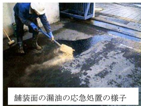
舗装面の漏油の応急処置の様子
