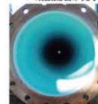
フレーク2層目塗布後、管内状況
