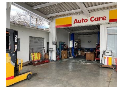
SS内のピット（木材加工作業にも利用）
