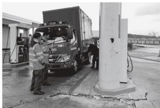
ひび割れができたSSで緊急車中に給油する徳間専務
