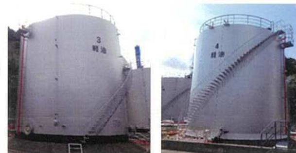
〈施工完了後各タンク〉
