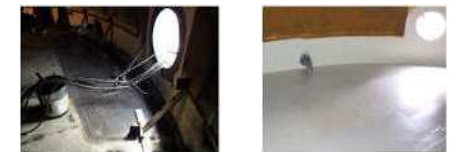
〈補修施工・完了〉
