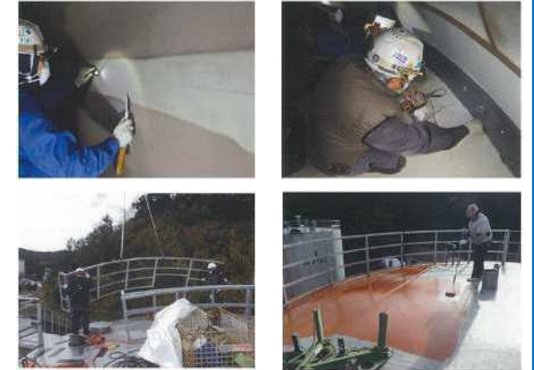
〈検査及び改修施工状況〉
