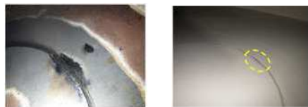
〈補修施工・完了〉
