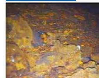
地下タンク内部の腐食状況
