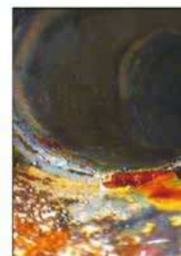
配管ジョイント部溶接不良
