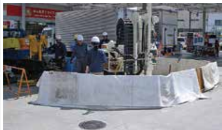
SS営業中浄化工事（参考写真）
